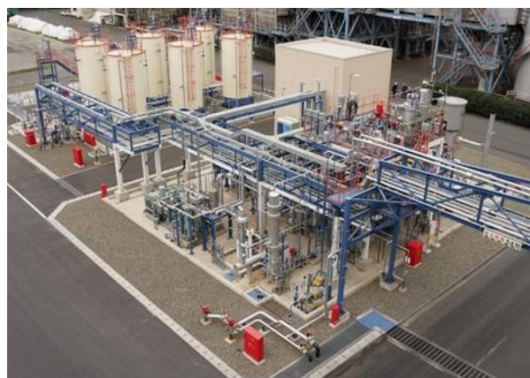
図11 脱水素反応装置 (川崎側)
