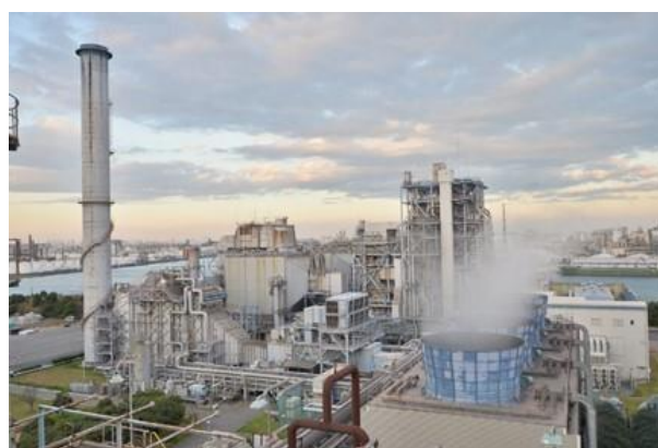
図12 東亜石油水江発電所
