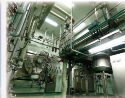
ケミカルハザード対応設備
