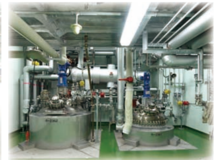
フレキシブルな製造を実現する独立セル方式
