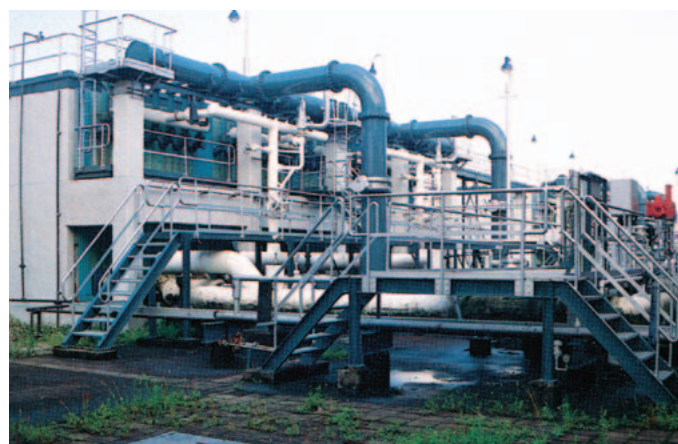
Open Rack Type Vaporizer (ORV)
