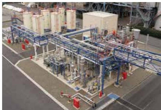
川崎臨海部の脱水素プラント
