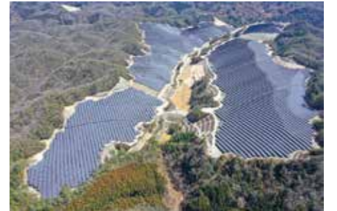
パシフィコ・エナジー(株)向け豊田メガソーラー発電所
