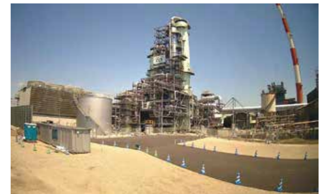
CCS事業の実証設備建設工事
