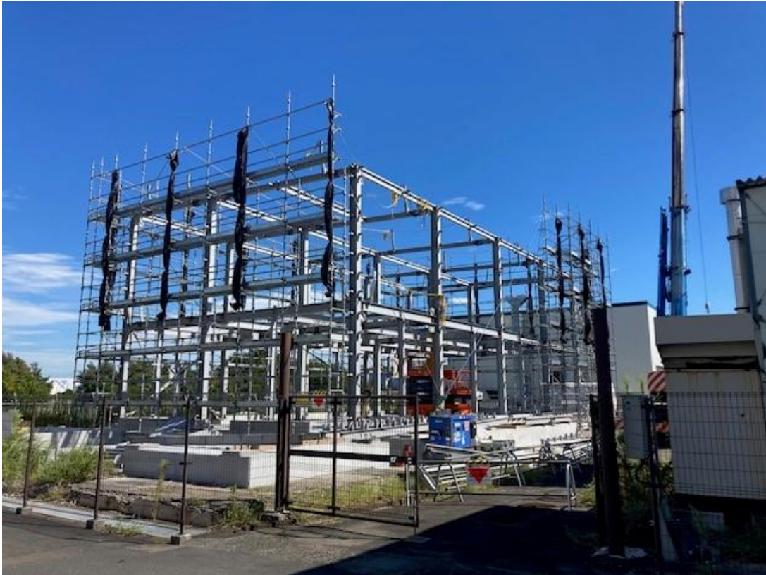
図3. 実証設備 建設現場
