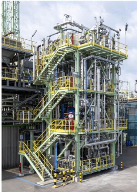
導入された Qpinch 設備 (所在: ベルギー、アントワープ) 写真: ©2021 Borealis.
