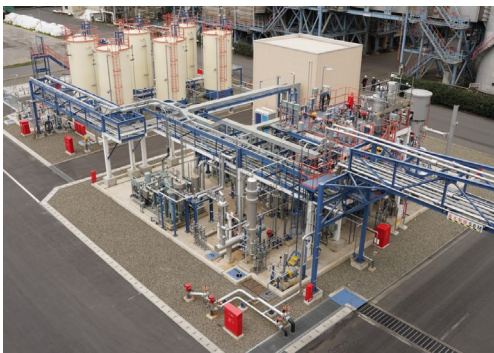
川崎臨海部脱水素プラント
