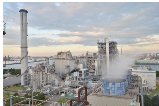
水素供給先ガスタービン (写真提供: 東亜石油株式会社)
