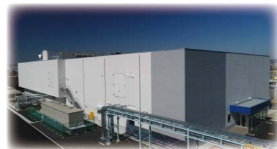
注射製剤棟 全景2階建 4,300㎡
