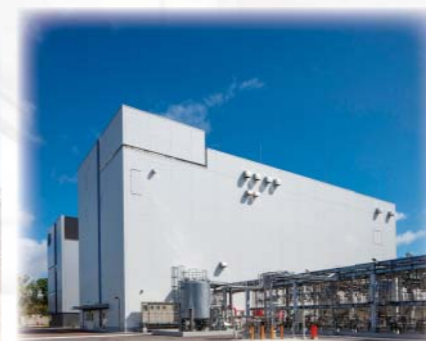
世界最大スケール特殊環状ペプチド原薬生産工場
