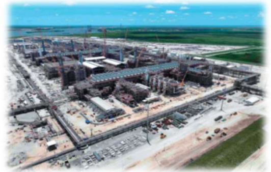
建設中のGolden Pass LNG(写真提供: Golden Pass LNG Terminal社)
