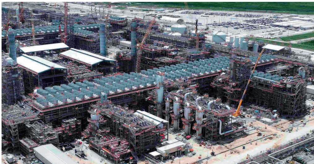
建設中のGolden Pass LNG (写真提供：Golden Pass LNG Terminal社)
