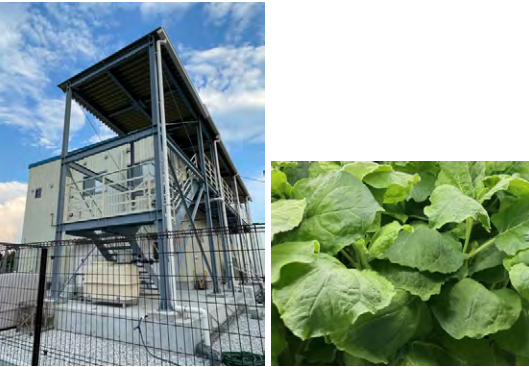
植物バイオ実証棟と栽培中の植物
