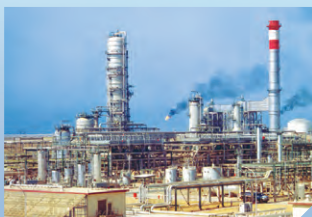
ペトロミン社、モービル社 サウジアラビア・ヤンブー製油所
