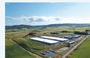
蓄電池システム外観
