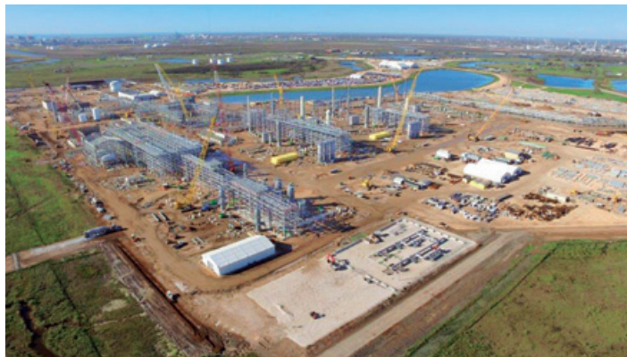
米国フリーポートLNGプラント (Courtesy of Freeport LNG Development, L.P.)
