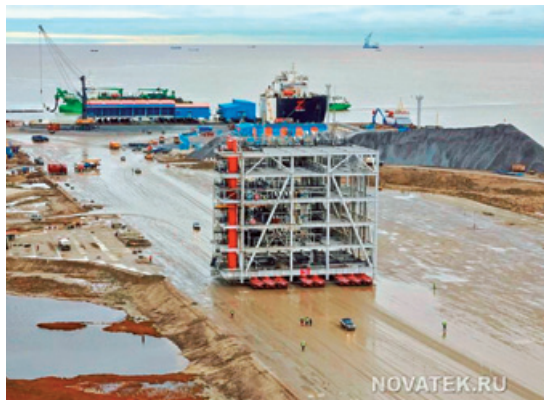
ロシア ヤマルLNGプラント
