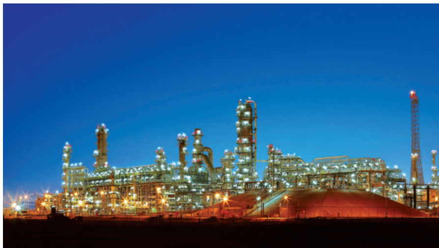
完成したカタールのラファンリファイナリー拡張工事 (Courtesy of Qatargas Operating Company Limited)
