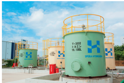
水素貯蔵タンク
