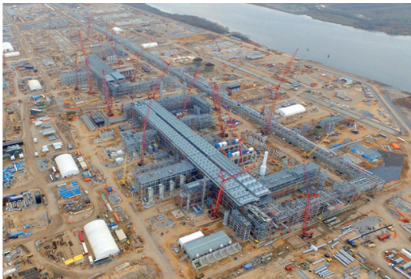
米国のキャメロンLNGプラント
