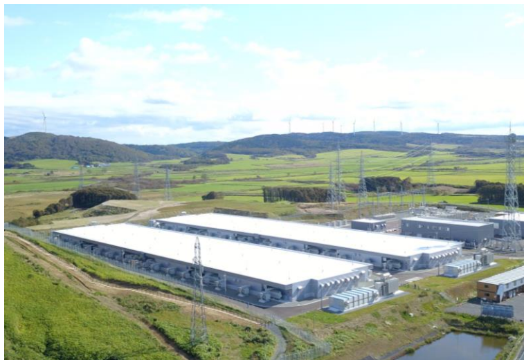
蓄電池システム外観
