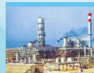
1984年 ベトロミン社、モービル社 ヤンプー製油所完成 (サウジアラビア)
