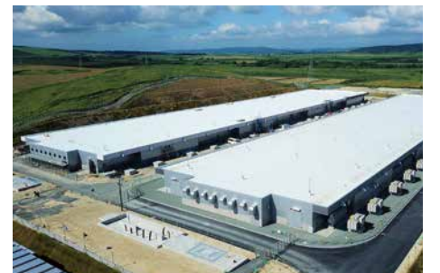
北海道北部風力送電(株)向け蓄電池システム建設現場(2020年7月撮影)
