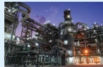
2004 カタールガス3&4社向けLNGプラント受注
