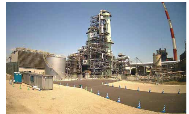
CCS事業の実証設備建設工事
