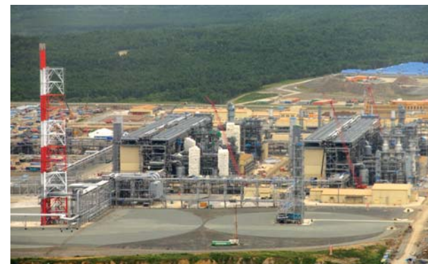
LNGプラント中心部
