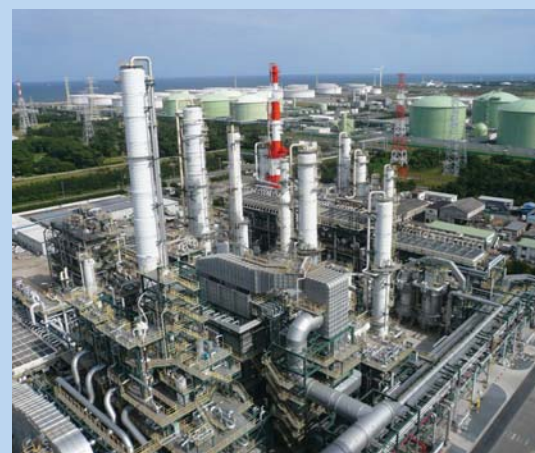
鹿島アロマティックス(株)アロマコンプレックス
