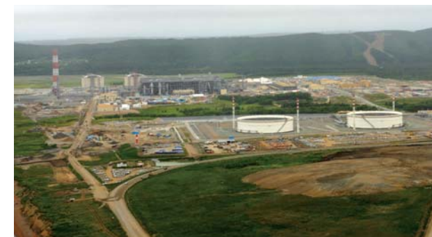
OETタンク設備
