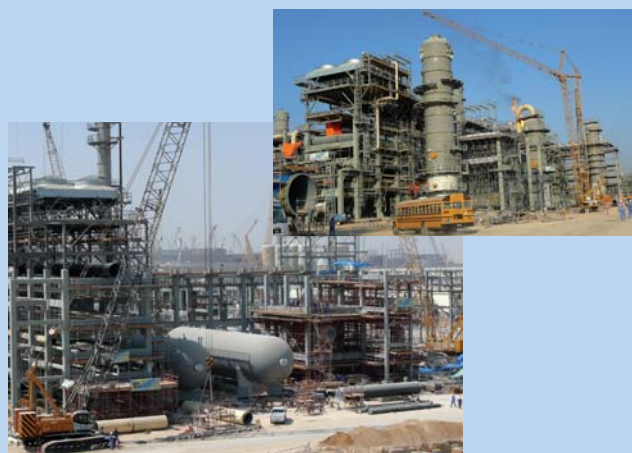
カタールで建設中のLNGプラント
