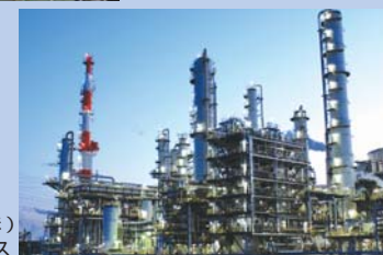
鹿島アロマティックス(株)アロマコンプレックス
