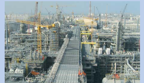
カタールで建設中のLNGプラント
