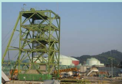
建設中のLPG国家備蓄プロジェクト(波方基地)
