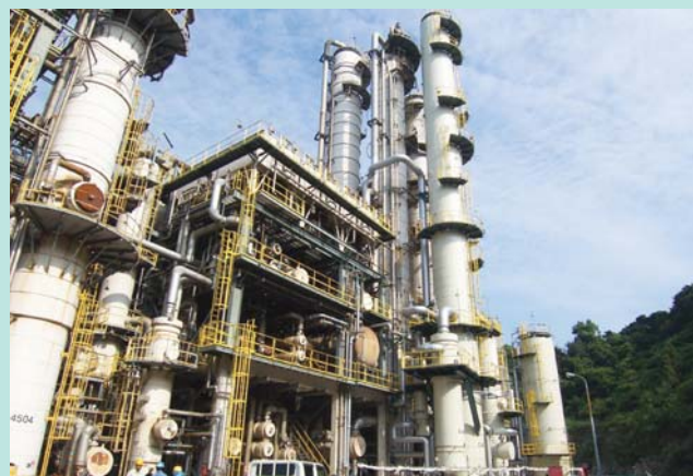
増強工事を行った 太陽石油(株) BTXプラント
