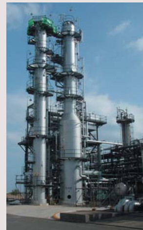
西部石油(株)向けガソリン硫黄低減化工事
