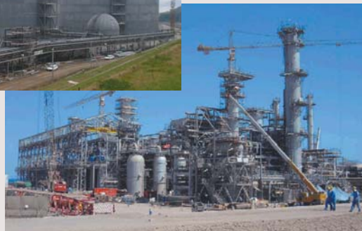
オマーン向けLNG液化設備建設工事
