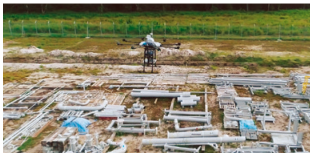
ブルネイでのドローン運用写真 (株式会社スカイマティクス提供)
