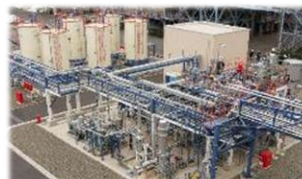
東亜石油(株)京浜製油所内 脱水素プラント*3
