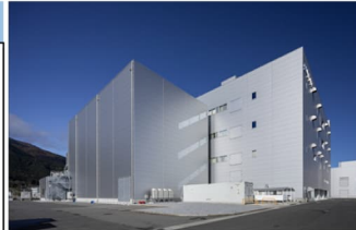
塩野義製薬(株)殿向けワクチン製造設備外観
