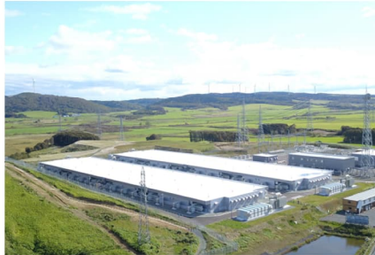
蓄電池システム外観
