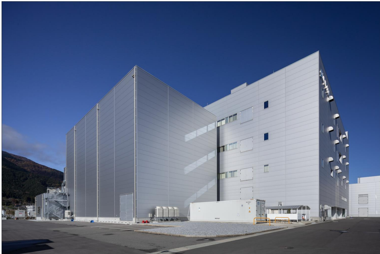
ワクチン原薬製造設備外観
