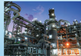
LNG Plants 3 & 4 for Qatargas Operating Co Ltd.
