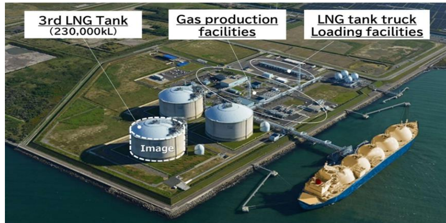
Hibiki LNG Base (Courtesy of Saibu Gas Co., Ltd.)
