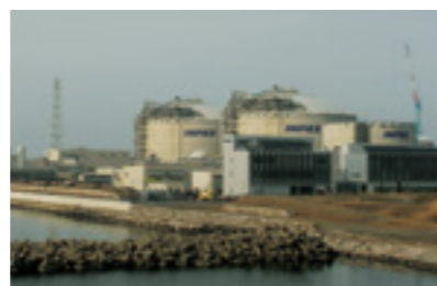
Naoetsu LNG receiving terminal
