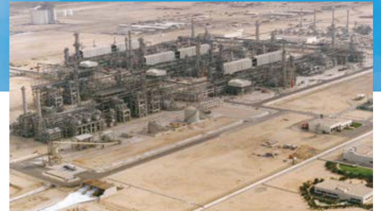
QATARGAS社(カタール) LNGプラント(トレイン1&2)
