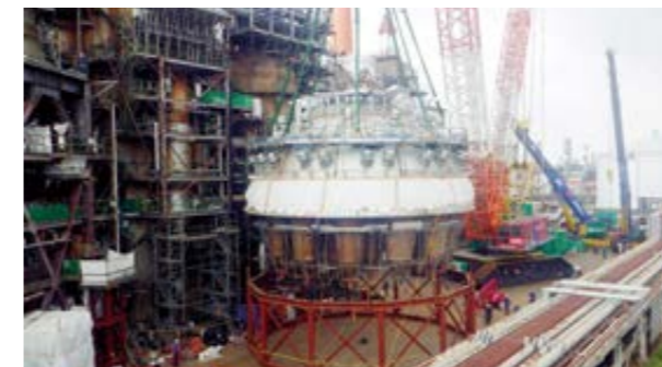
国内最大となる直径16mの再生塔 塔頂部
