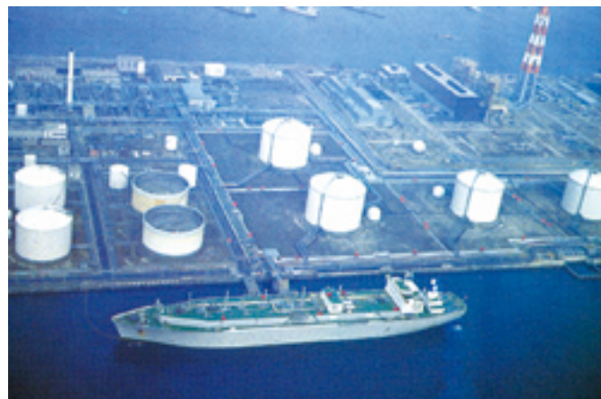
Japan's first LNG receiving terminal, Tokyo Gas Co., Ltd.'s LNG receiving terminal in Negishi
