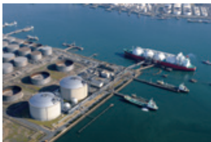
LNG receiving terminal of MIZUSHIMA LNG COMPANY, LIMITED (Photo courtesy of MIZUSHIMA LNG COMPANY, LIMITED)
