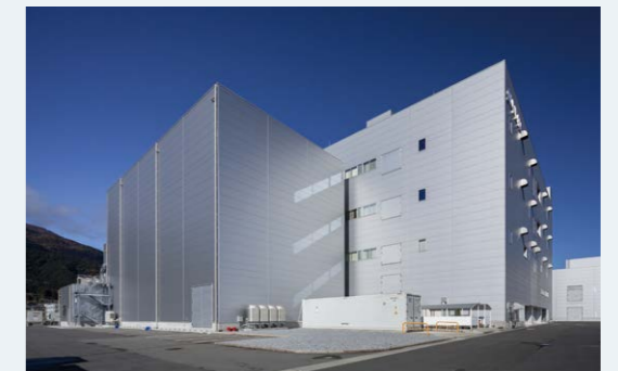
塩野義製薬(株)向けワクチン製造設備外観
