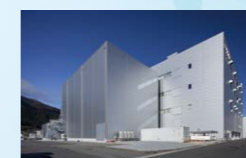
塩野義製薬(株)向けワクチン製造設備外観
