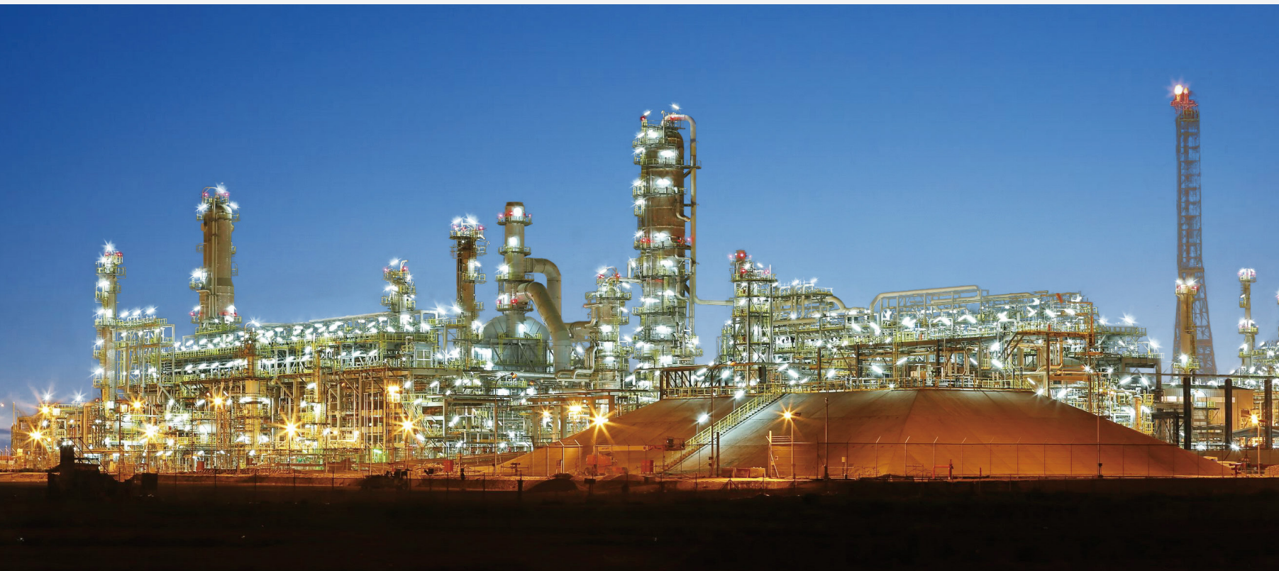
ラファン第2製油所(カタール)
